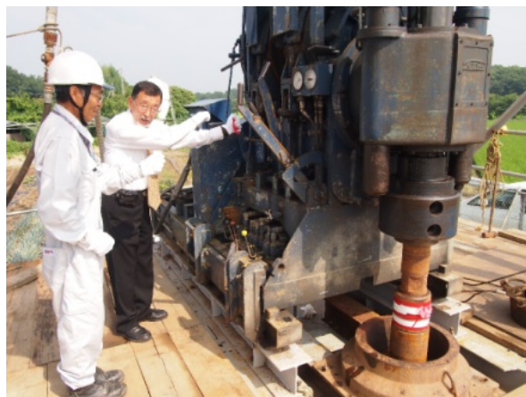
掘削機の始動レバーを引いて機械を動かす多田理事長
