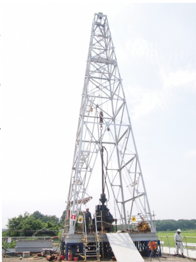
深さ約1500mの深さを掘る、高さ約25mのやぐら
