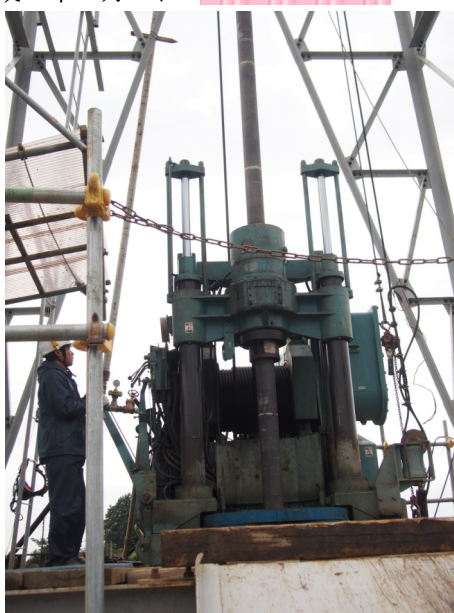
掘削が行われたドリル
